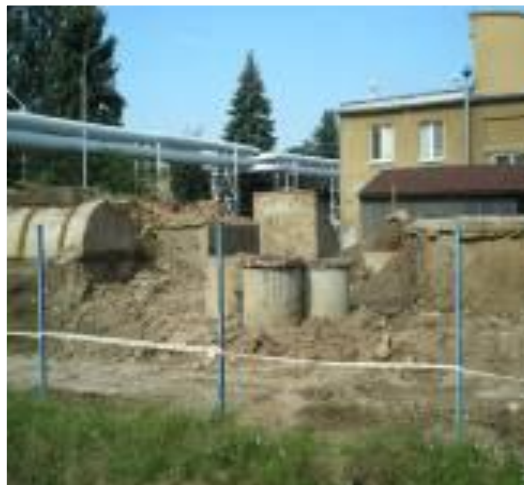
Usunięcie zbiorników podziemnych
